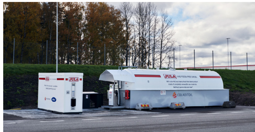
En tankstation för HVO, hydrerad vegetabilisk olja, på Julas lager i Skara, Sverige.
